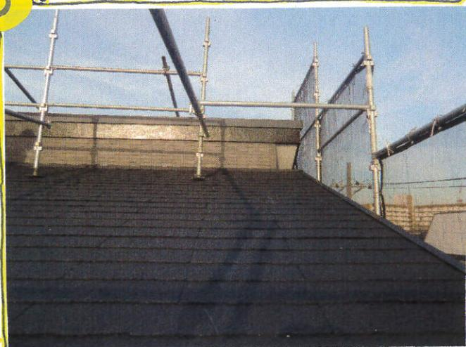
完成: 断熱材と一体型の材料を張ってい
